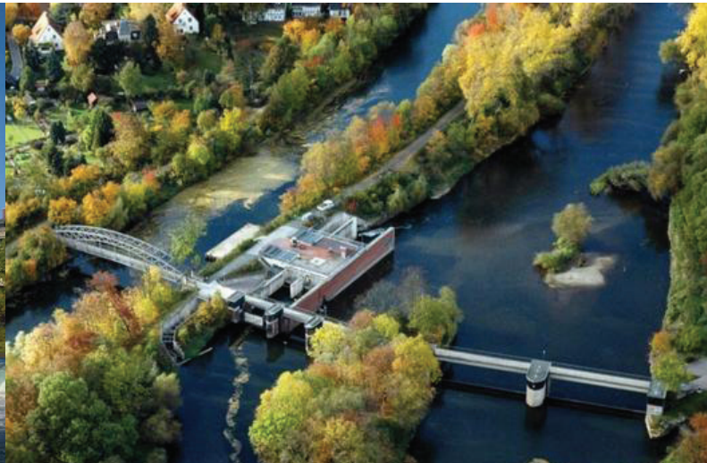
Abb. 2: Luftaufnahme des Wasserkraftwerkes in Herrenhausen (HAZ)
