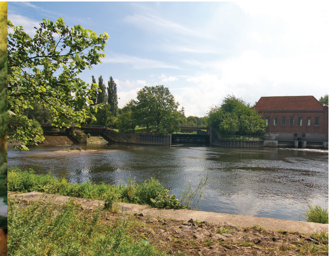
Abb. 3: Wasserkraftwerk am Schnellen Graben
