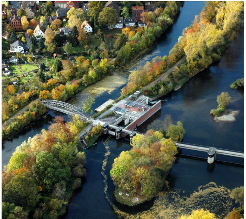
04 Luftbild /Das Wasserkraftwerk mit Fischtreppe von oben.
