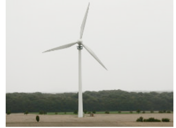
10 WEA-Kronsberg /Die Windenergieanlage E-66 wurde im Zuge der Expo 2000 errichtet, und ist die letzte von ursprünglich drei Anlagen. Momentan finden leider keine Besichtigungen statt.
