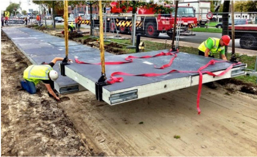
Abbildung 11: Bau der ersten Solarstraße in Europa als 70 Meter langer Fahrradweg in Krommenie (Firma SolaRoad).
