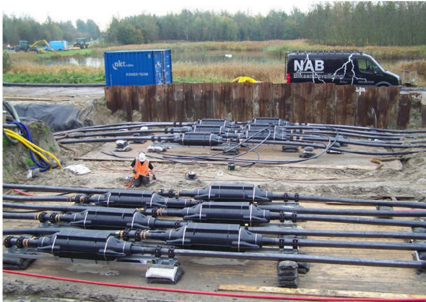
Abb. 16: Kabelmuffenstelle (aus TENNET TSO GMBH 2016)
