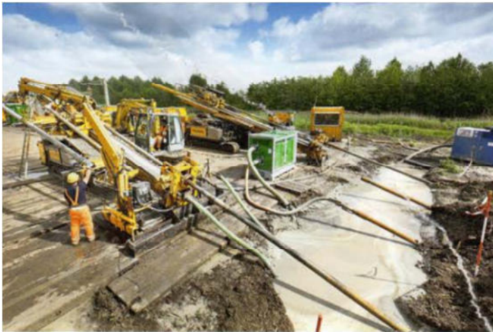
Abb. 19: Gesteuerte Bohrung zur Teilverkabelung (aus TENNET TSO GMBH 2016)
