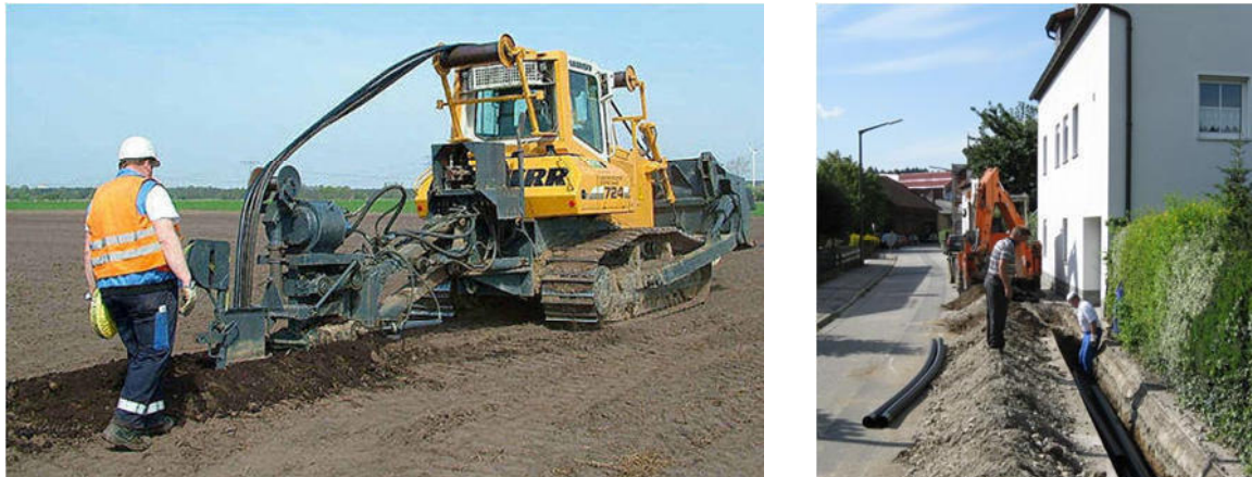
Abb. 29: Mittelspannungs-Kabellegung mit einem Vibrationspflug, Foto: CATRIN WÜRZ und Kabellegung bei offenem Graben für die Niederspannungsebene in einem Wohngebiet, Foto KOLBECK BAU
