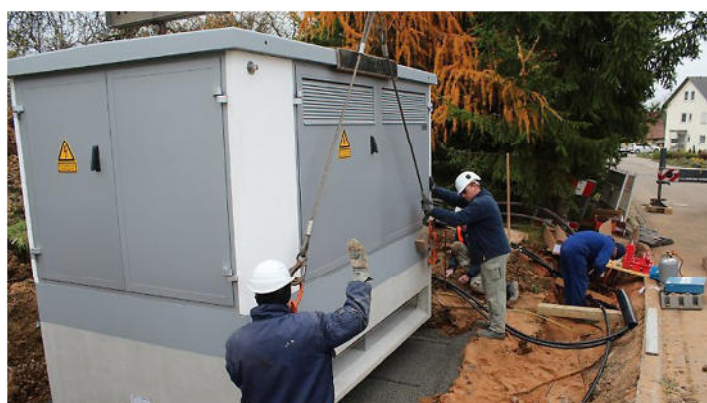
Abb. 32: Prinzipschaltbild und Aufstellung einer Ortsnetzstation, Foto: ENBW
