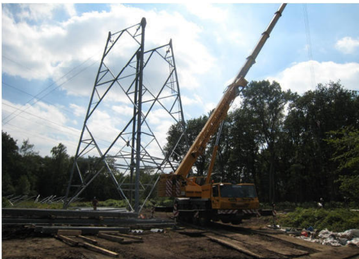
Abb. 12: Neubau eines Freileitungsmastes in Castrop-Rauxel (Foto: TBACHNER/WIKIMEDIA COMMONS, LIZENZ: CC-BY-SA-3.0)
