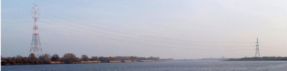
Abb. 5: Elbekreuzung bei Stade, der Blick zeigt den Anstieg der Leitungen vom 76 m hohen Abspannmast zum südlichen 227 m hohen Tragmast (Foto: KREUZSCHNABEL/WIKIMEDIA COMMONS, LIZENZ: CC-BY-SA-3.0)
