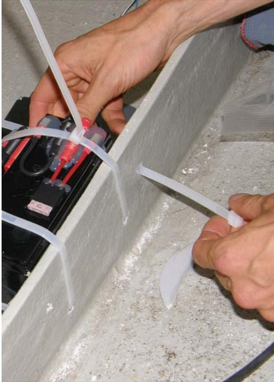
**Abbildung 9** Befestigung des Blei-Gel-Akkus mit Kabelbindern (Breite 8 mm). **Im Bild sind zwei Akkus gezeigt, für den Aufbau wird jedoch für jeden Detektor nur jeweils einer benötigt!**
