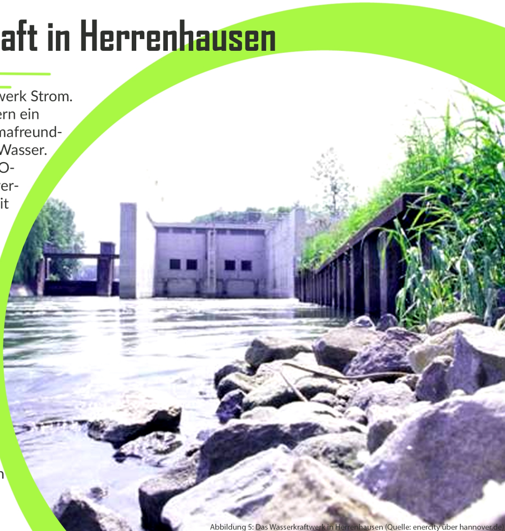
Abbildung 5: Das Wasserkraftwerk in Herrenhausen (Quelle: enercity über hannover.de)
