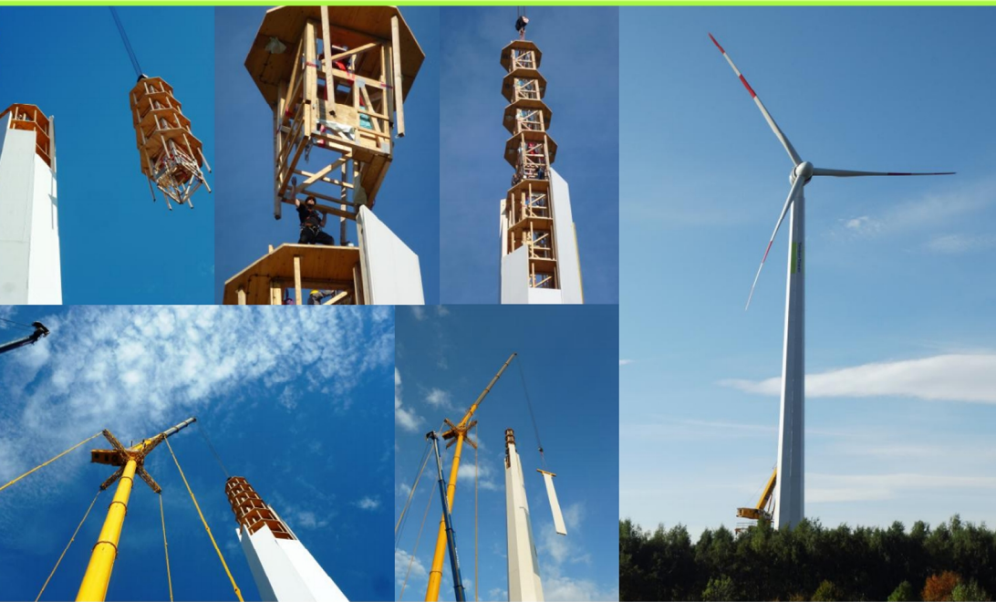
Abbildung 4: Konstruktion des Timbertowers (Quelle: Cordes Holzbau)
