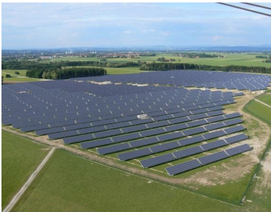
Abb. 6: Photovoltaik-Freiflächenanlage mit starr in Reihe montierten Solarmodulen (BUCHER 2006: www )
