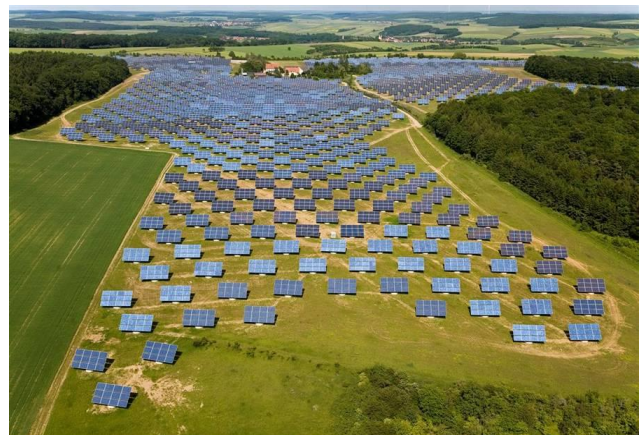
Abb. 5: Photovoltaik-Freiflächenanlage mit nachführbaren Solarmodulen (SOLON SE 2010: www )
