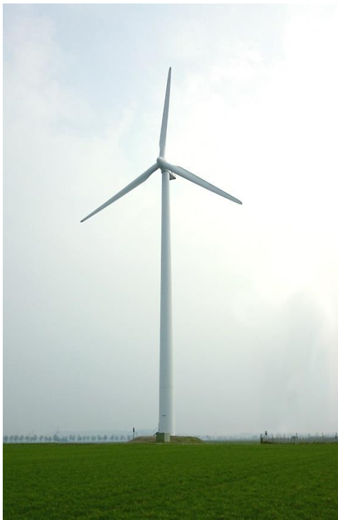
Abb. 4: Windkraftanlage (EIGENE AUFNAHME)
