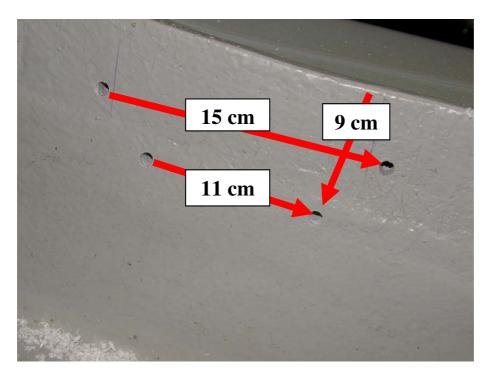
Abbildung 7 8 mm Bohrlöcher zur Befestigung des Blei-Gel-Akkus an der GFK-Falz
