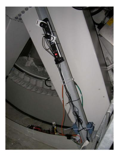
Abbildung 6 Position der Steckerleiste (oben am U-Träger um die Treppe frei zu halten) und der Bleiakku-Ladegeräte (unten seitlich am U-Träger) im Keller der WEA-Gondel
